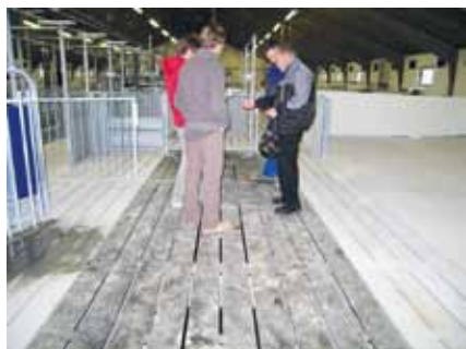
Gummibelægning fra ErgoFloor (venstre) DUO-spalter fra Sunds (højre) Belægningerne er lagt midt i aktivitetsområdet, hvor det forventes at de fleste rangkampe er.
