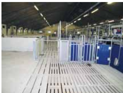
Gummibelægning fra ErgoFloor (venstre) DUO-spalter fra Sunds (højre) Belægningerne er lagt midt i aktivitetsområdet, hvor det forventes at de fleste rangkampe er.
