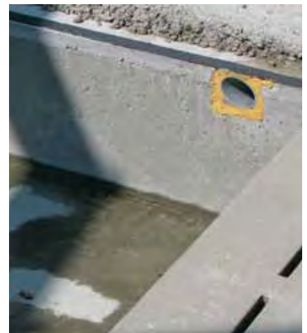
I en drægtighedsstald med én boks pr. so er sugepunkterne jævnt fordelt under det delvist faste gulv i hver boksrække.
