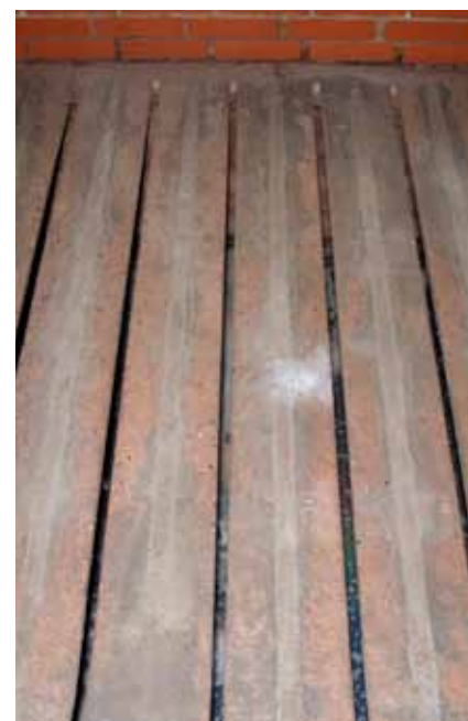
Fuldspaltegulvet er ændret til drænet gulv ved at lukke halvdelen af spalteåbningerne med en tyndtlagsmørtel.
