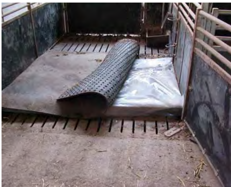
Sygesti med gummimåtte. Lejet vil fremstå tørt, forudsat der etableres ca. 5 % fald på underlaget.
