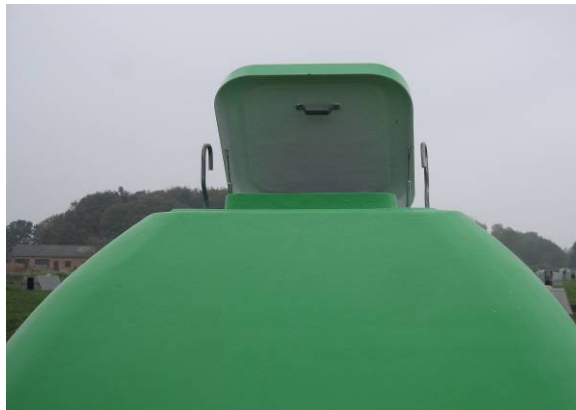
Foto 10. Ventilationsluge med automatisk åbning placeret i toppen af hytten.
