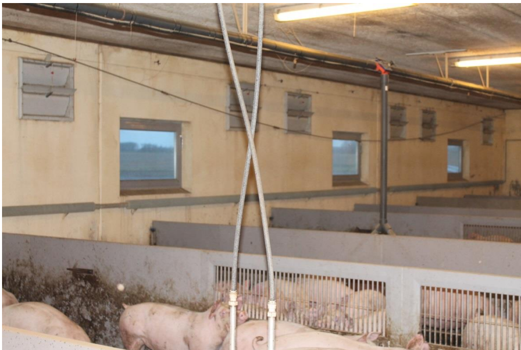
Billede A2. Forsøgssektion der blev anvendt i afprøvningen. På billedet ses bl.a. vægventiler, som blev anvendt som supplerende luftindtag.
