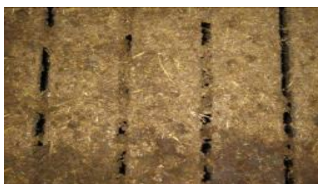
Figur 6. 2.: Delvis tilkitning. Delvis tilkitning af spalteåbning. Der ligger gødning og halm i spalteåbningen, men der er stadig mulighed for gødningsgennemgang.
