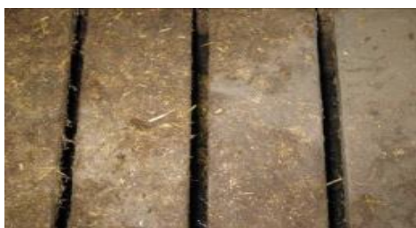
Figur 6. 1.: Ingen tilkitning. Ingen tilkitning af spalteåbning. Spalteåbningerne er fri for tilkitning og der er fri passage for gennemgang af gødning.
