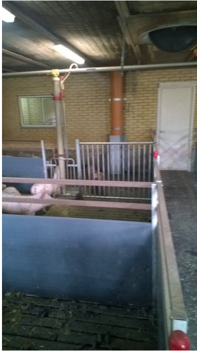
Billede 1. Punktudsugningsanlægget i staldrummet og på loftet.
