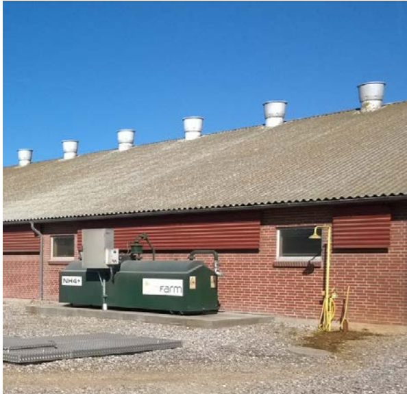
Figur 1. Venstre: "NH 4 + Staldforsuring" i afprøvningsbesætningen. Højre: (1) Gylle løber fra stalden til processtanken (2). I processtanken tilsættes svovlsyre for at justere pH niveauet til 5,5 (3). Størstedelen af den behandlede gylle pumpes tilbage til stalden for at reducere ammoniakfordampningen (4). Resten af gyllen pumpes til lagertanken.
