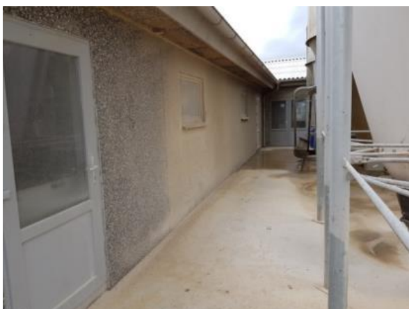
Figur 29. Udluftning via silo ben (Foto: Christian Schädler)
