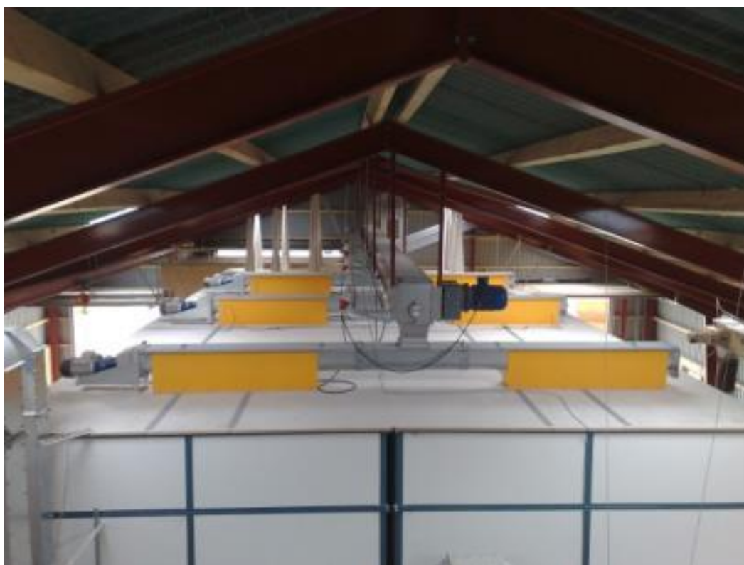
Figur 17. Top af råvaresiloer med lange udløb for optimal fyldning (Kilde: SKOLD A/S)
