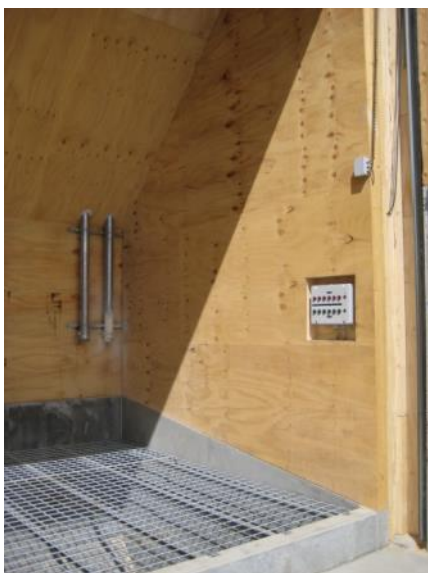
Figur 10. Korngrav med støvkasse, rist og betjeningspanel (SKIOLD A/S)
