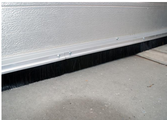
Figur 14. Port med "Børstetætning" (Kilde: NASSAU Door A/S)
