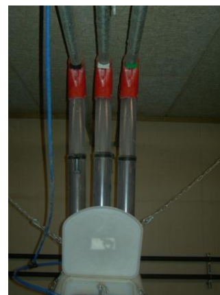
Eksempel på fasefodringsanlæg med tre rørstrenger.
