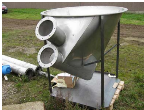
Foto 1.7 Assentoft silo under etablering: Keglebunden i rustfrit stål før faststøbning i siloens betonbund
