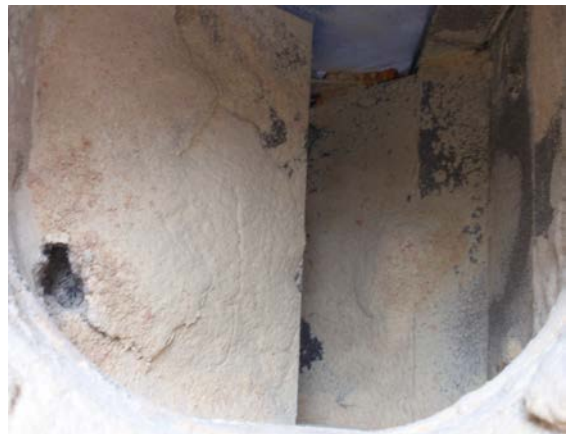
Foto 2.6 Løse belægninger, der vil kunne løsne sig og forurene foderet med skimmelsvampe.
