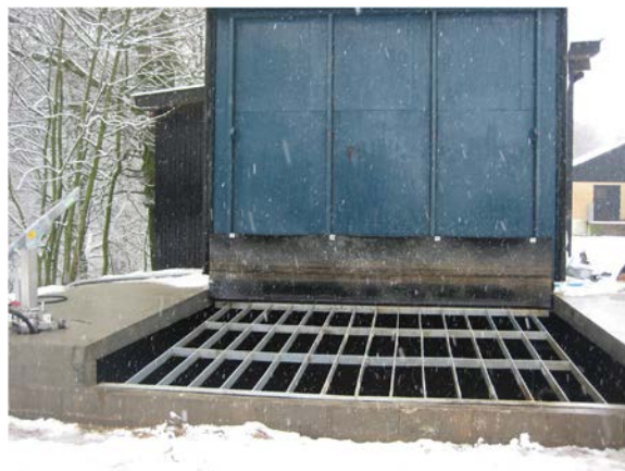
Foto 1.30 Påslag til opblending i vand eller valle og evt. sammen med våde biprodukter. Vejning via brovægt eller frontskovl med vægt.
