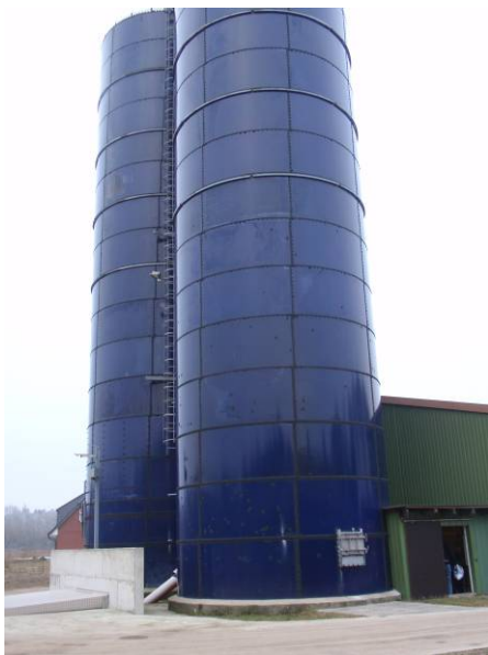
Foto 1.1 Harvestore siloer med Silohaake udtagesystem. Fyldning sker via en kop-elevator fra korngraven foran.
