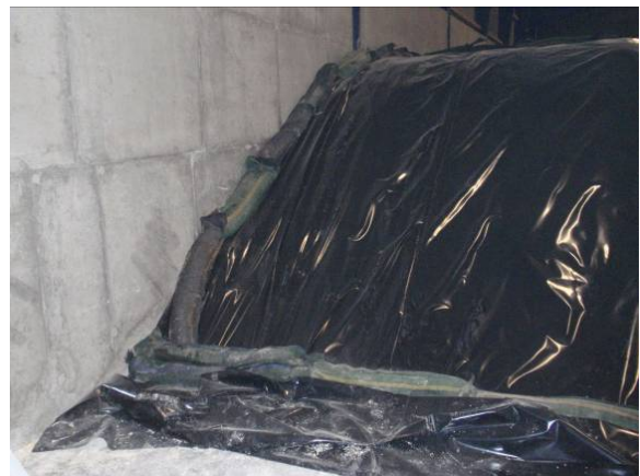
Foto 1.17 Dækning: Plast fra sider og top blev lagt, så det overlappede med ca. 2 m. Der blev lagt sandsække langs alle kanter og sandsække eller dæk på overfladen.
