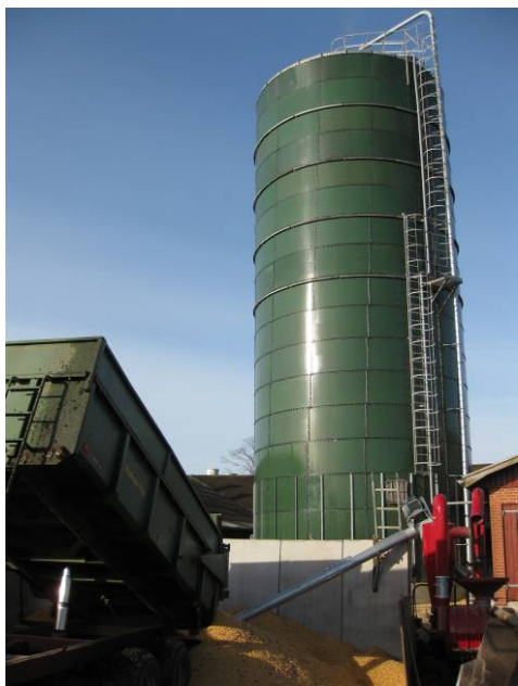
Foto 1.6 Assentoft silo med keglebund. 20 m høj og 7,2 m i diameter. Keglebunden kan ifølge Assentoft anvendes op til en diameter på 8,5 m
