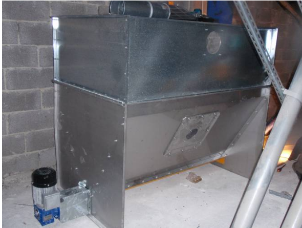
Foto 1.10 Assentoft: Påslag til majs fra gastæt silo. Senere blev påslaget droppet, fordi majsene dannede bro.
