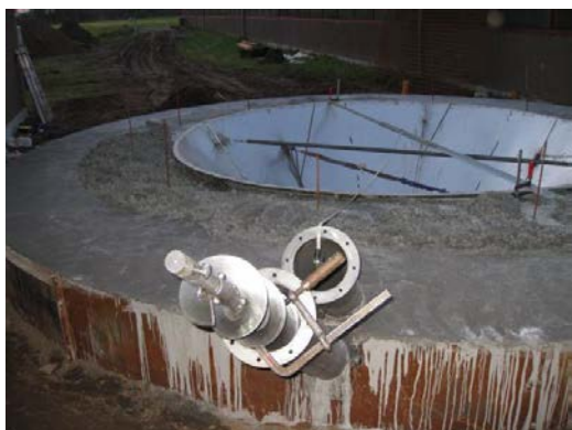
Foto 1.8 Assentoft silo under etablering: Stejl, rustfri stålkeglebund nedstøbt i silobund. Keglen er 3,25 m dyb og 4,2 m i diameter. Majsensnegles fra keglebunden og ud af siloen.
