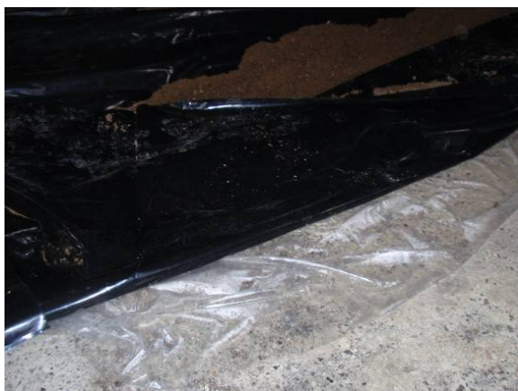
Foto 1.16 Dækning: Stakken blev dækket først med et tyndt lag plastfolie, der lægger sig helt tæt og lufttæt til overfladen. Ovenpå blev lagt et kraftigere plastfolie til beskyttelse af stakken.
