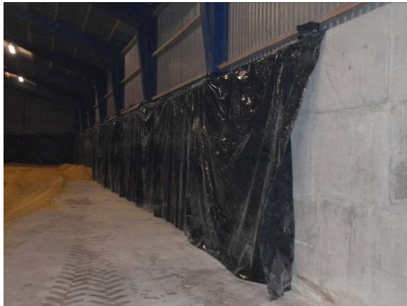
Foto 1.14 Før høst: siloen blev rengjort og silovæggene dækket af plastfolie
