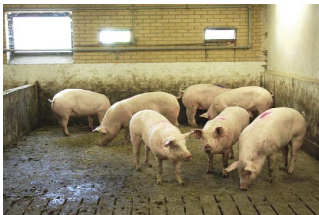
Figur 2. Leje før etablering af halmbræt.
