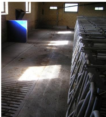
Figur 13. I stien med leje parallel med æde-/hvileboksene blev det faste gulv bag boksen (tidligere gangareal) riflet for at øge skridsikkerheden (gruppe 2).
