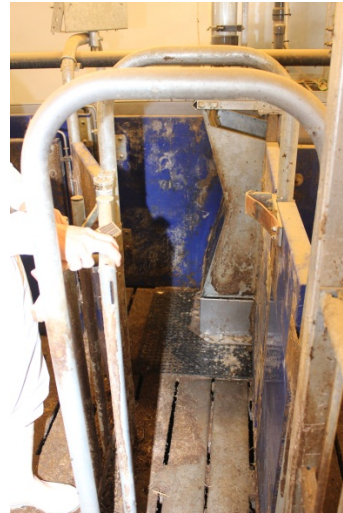
Figur 17. Big Dutchman – sidehængslet låge, der åbner op ad et inventarstykke.
