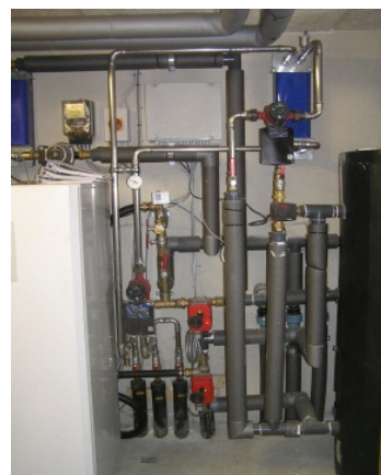
Figur 11. Varmepumpe med bidrag fra henholdsvis gylle- og gulvkøling.
