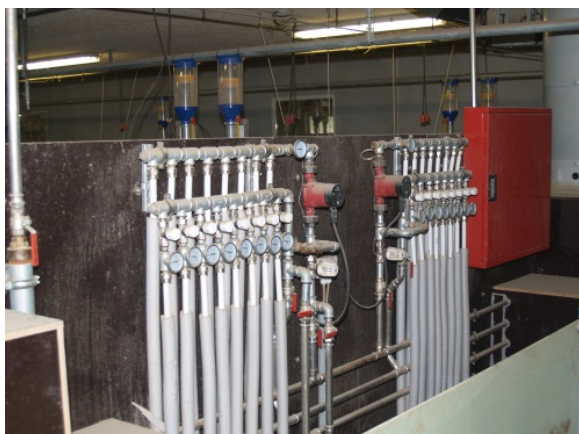
Figur 10. Kredsløbet til venstre forsyner soens område, og kredsløbet til højre pattegrisehulen.
