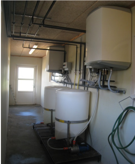
Figur 1. Anlæggets tanke med tilhørende varmtvandsbeholder placeret for enden af en gang nær faresektionerne. Faresti i forsøgsgruppen med mælkekopper. Farestier i kontrolgruppen var magen til men uden mælkekopper.
