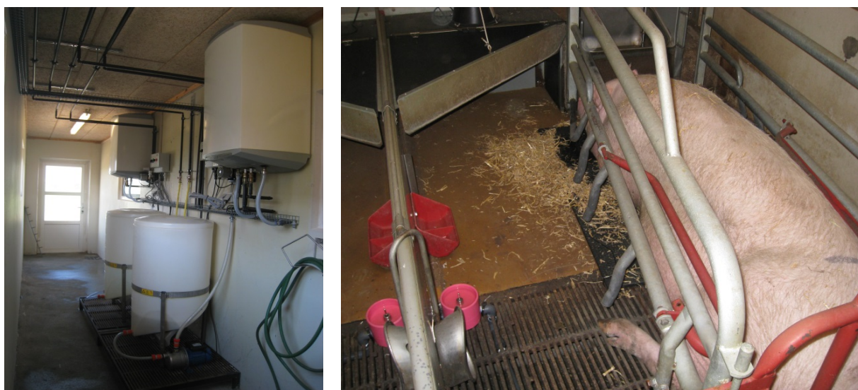
Figur 1. Anlæggets tanke med tilhørende varmtvandsbeholder placeret for enden af en gang nær faresektionerne. Farestier i forsøgsgruppen med mælkekopper. Farestier i kontrolgruppen var magen til men uden mælkekopper.
