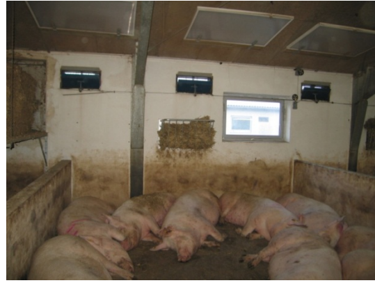
Figur 2. Situation hvor ledepladerne over lejet ikke er i funktion.
