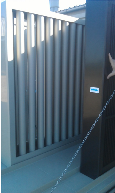
Figur 2. De to dråbefang kan manuelt trækkes ud i forbindelse med rengøring.
