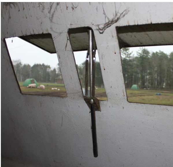
Billede 9. Automatisk styring af ventilationsåbning
