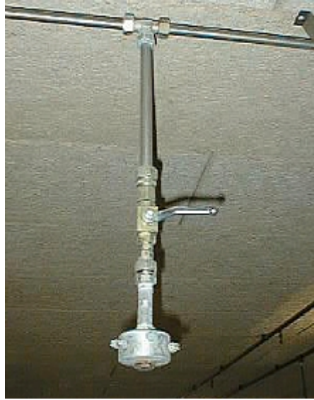
Foto: Højtryksrensning via udtag monteret i sektionen (billededatabase nr. 5912)
