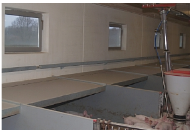
Foto: Rør til rumvarme placeret korrekt over overdækningen (billededatabase nr. 1116)
