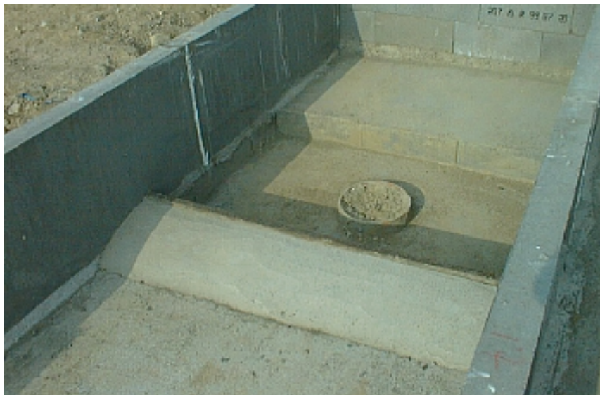
Foto: Gyllekanal med prop (billededatabase nr. 5820)
