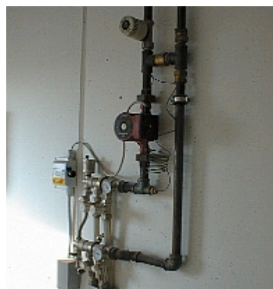
Foto: Rør til rumvarme placeret korrekt over overdækningen (billededatabase nr. 1116)
