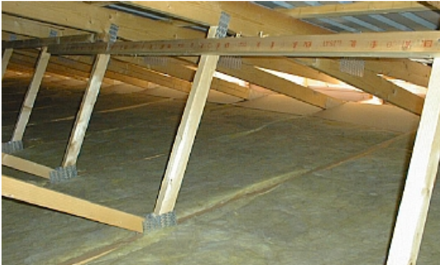
Foto: Diffus ventilation hvor luften indtages over hele lofflader (billededatabase nr. 6299)
