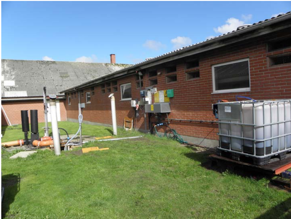
Figur 1. Det afprøvede forsøringsanlæg fra JH Forsuring var et prototypeanlæg. På billedet ses s yrebeholder på vejeceller og procestank, hvor selve forsuringen af gylle foregik. I procestanken var der installeret to pH-følere og doseringen af syre under omrøring blev styret ud fra gyllens pH. Prototypeanlægget var afskærmet fra omgivelserne med et hegn.
