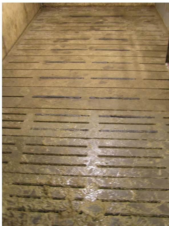
Figur 4. Udformning af gulv i gruppe 4 – bemærk de isatte gummikiler.
