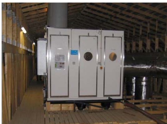
Figur 1. Øverst tv.: Udtagning af lugtprøver i ventilationsafkast i sektion med forsuring. Øverst th.: Procestank i forsuringsanlæg. Midten tv.: Skærbillede af kontrolpanel til forsuringsanlæg. Midten th.: Syretank til forsuringsanlæg. Nederst tv.: Biologisk luftrensingsanlæg installeret på loftet over sektion med slagtesvin. Nederst th.: Udtagning af lugtprøver i afkast fra biologisk luftreenser.
