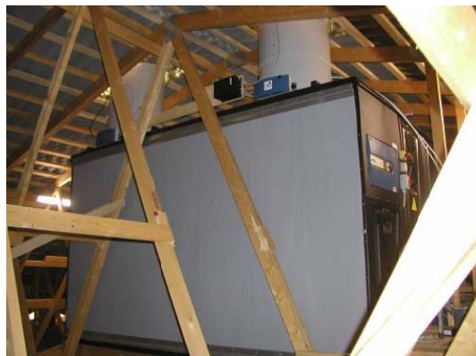
Figur 1. Øverst tv.: Udtagning af lugtprøver i ventilationsafkast i sektion med forsuring. Øverst th.: Procestank i forsuringsanlæg. Midten tv.: Skærbillede af kontrolpanel til forsuringsanlæg. Midten th.: Syretank til forsuringsanlæg. Nederst tv.: Biologisk luftrensingsanlæg installeret på loftet over sektion med slagtesvin. Nederst th.: Udtagning af lugtprøver i afkast fra biologisk luftreenser.
