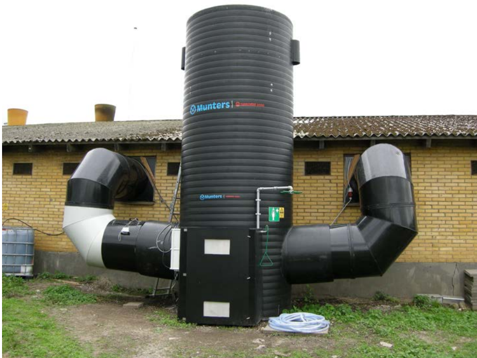
Figur 1. Luftrenser med syre fra Munters etableret ved slagtesvinestald.
