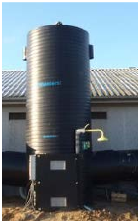
Figur 1. Luftrenser med syre fra Munters A/S etableret ved en slagtesvinestald.
