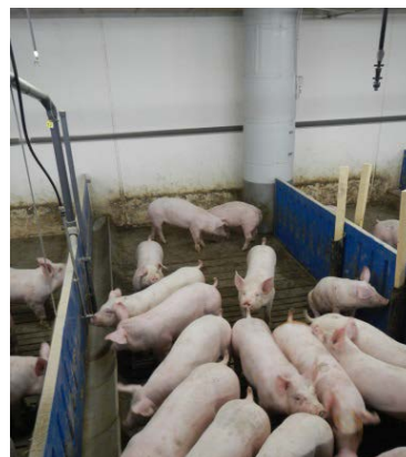
Foto 2. Kanal som fører staldluften fra punktudsugningskanalen til centralkanal placeret på loftet.
