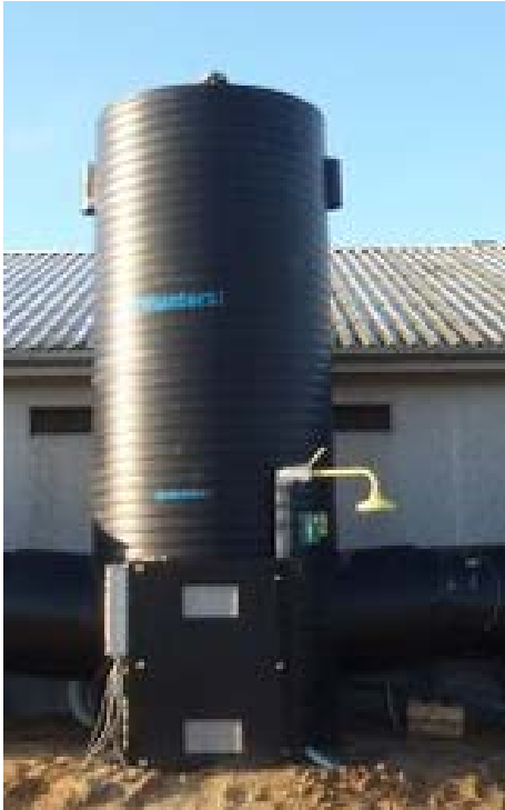
Figur 1. Luftrenser med base fra Munters A/S etableret ved en slagtesvinestald.
