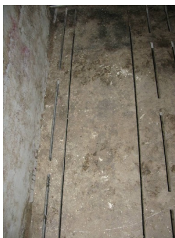
Figur 3. Fastgulvselement hen over Ø400 røret for at undgå urin og gødning i sugepunktet.
