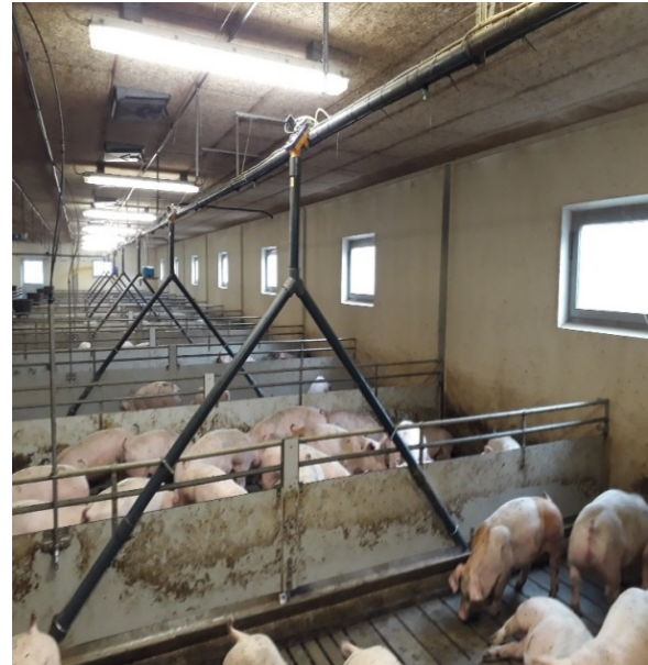
Figur 3. Produkttank for Aks2tal med pumpe-tilkobling og styring (billede t.v.) og rørsystem og dyse installation i staldafsnit (billede t.h.).
