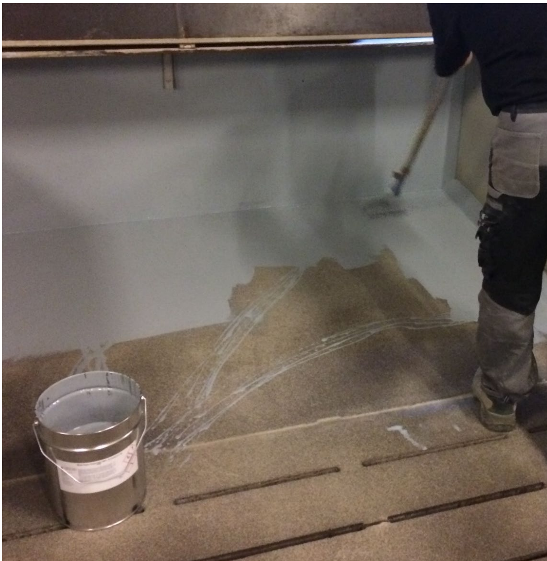
Figur 3. Der blev etableret trelaget-epoxyoverflader på gulve og hulevæg. Det midterste epoxylag på gulvet blev tilført strukturmateriale for at gøre gulvet skridsikkert.
