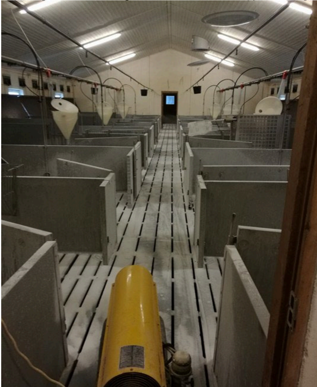
Figur 4. Sektion med epoxy som er vasket, desinficeret, kalket og udtørret. Nederst i billedet ses varmekanon, som blev brugt til at udtørre staldene med.
