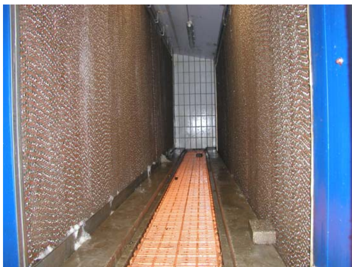
Figur 2.1. Filter i luftvasker fra Big Dutchman.
