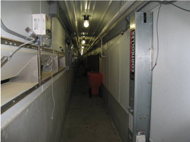
Figur 2.8. Vægventiler mellem gang og smågrisesektioner, på højre side af gangen ses køleanlægget (figur til venstre - (nr. 8147)). Smågrisesektion set fra forbindelsesgangen mod ydervæg med vægventilatorer (figur til højre - (nr. 8148)). David Meyer, South Dakota.
