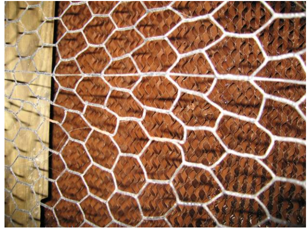
Figur 2.6. Drægtighedsstald med kølesystem og gardiner (figur til venstre – nr. 8144). Luften trækkes igennem elementer af pap, som overrisles med vand, hvorved luften nedkøles (figur til højre - nr. 8145), David Meyer, South Dakota.
