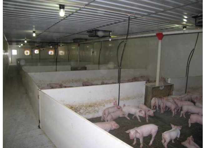
Figur 2.8. Vægventiler mellem gang og smågrisesektioner, på højre side af gangen ses køleanlægget (figur til venstre - (nr. 8147)). Smågrisesektion set fra forbindelsesgangen mod ydervæg med vægventilatorer (figur til højre - (nr. 8148)). David Meyer, South Dakota.
