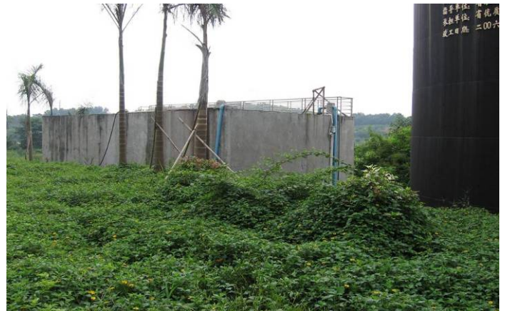
Tanken hvor gyllen efterfølgende beluftes.
