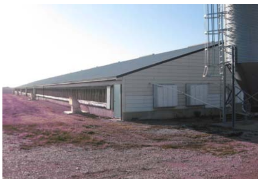
Foto 4 og 5. Eksempel på FRATS-stald med gardinventilation og gulvudsugning.
