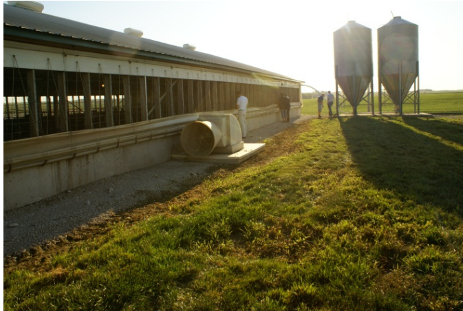
Foto 19. Gulvudsugning hindrer svovlbrinteforgiftning i stalde med gyllekældre.
