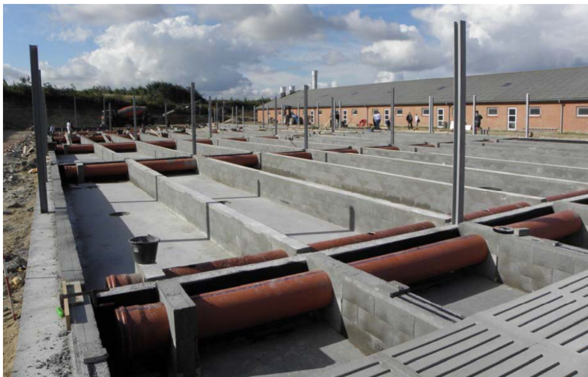
Figur 8. Etablering af punktudsugning i slagtesvinestald med henblik på delrensning af afgangsluften.
