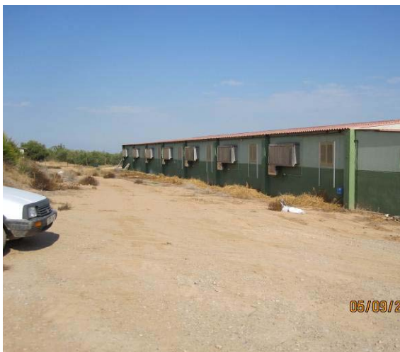
Køling af ventilationsluft ind i stalden
