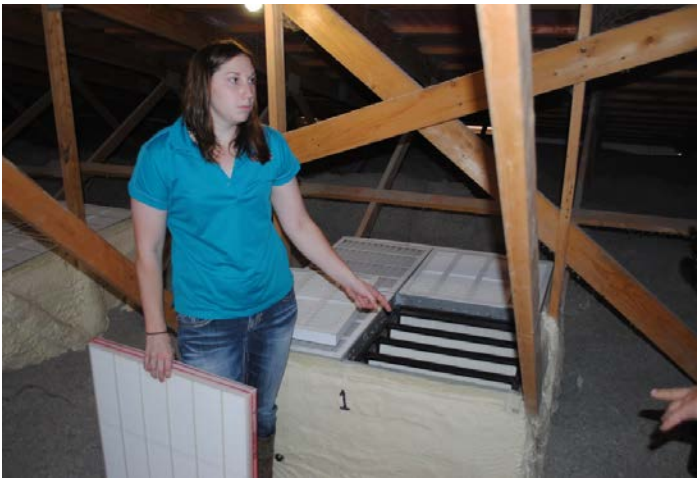
Foto 20: En del af de store sobesætninger sætter filtre på luftindtaget for at undgå smitte som f.eks. PRRS
