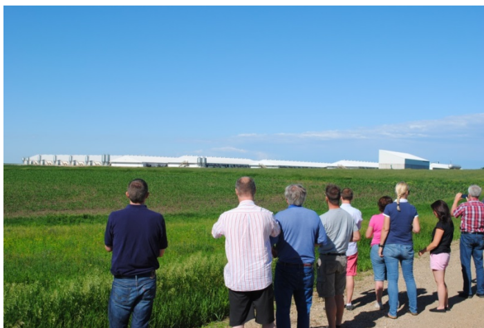
Foto 11: Opførelse af nyt so-anlæg
