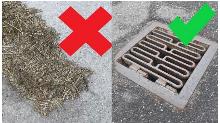
Billede af stoppet afløb og ikke tilstoppet afløb
