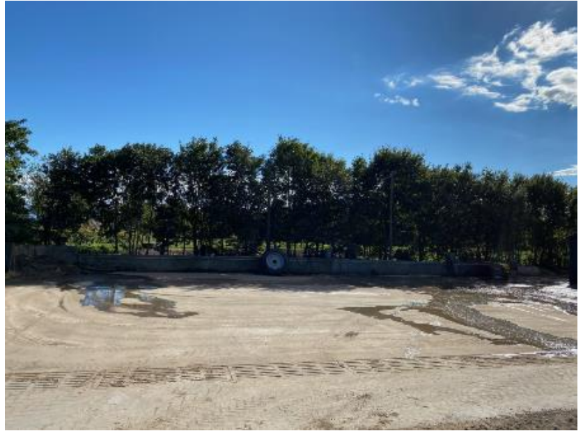
Billede af vaskeplads med aquadræn.
