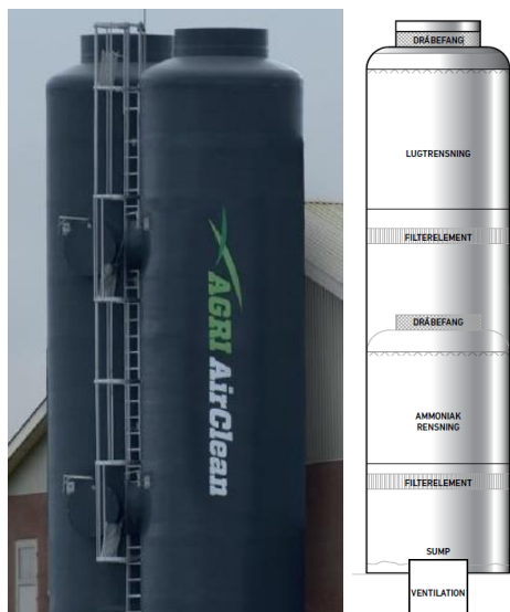
Billede af Agri AirClean kemisk luftrenser med både syre- og basetrin.
