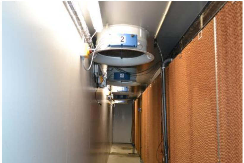
Billede af udsugning fra biologisk luftrenser fra Skov.
