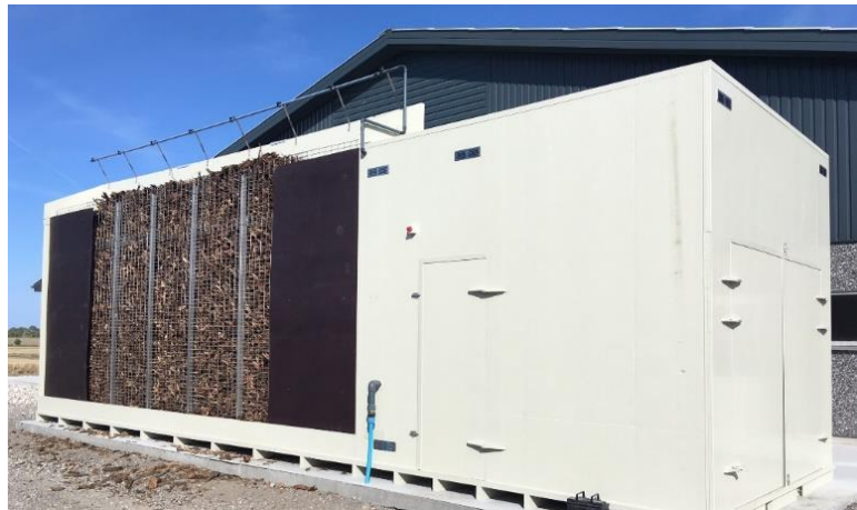
Billede af FAC Combi-Cleaner PE luftrenser fra Skov A/S. Det er en kombineret luftrenser med et syretrin til ammoniakreduktion samt et biologisk trin til reduktion af lugt.
