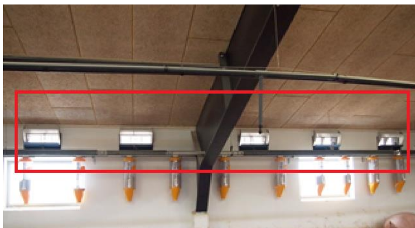
Billede af skorsten og vægventiler.
