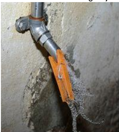
En simpel måde til gennemskylning af rør
