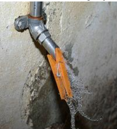
En simpel måde til gennemskylning af rør
