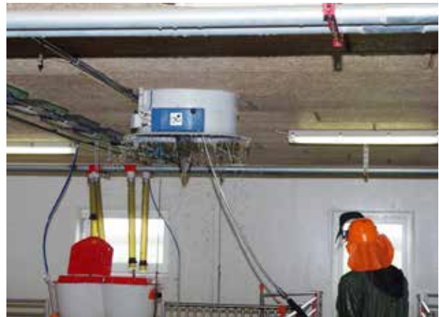
Figur 3. Rengøring af ventilationskorsten med højtryksrenser.
