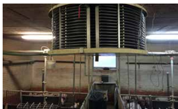
Figur 2. Man kan genindvinde varme fra udsugningsluften i ventilationsanlægget ved hjælp af en varmeoptager, der består af pexrør.
