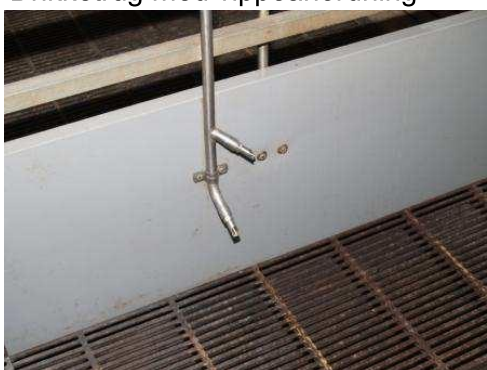
Vandventiler i forskellig højde
