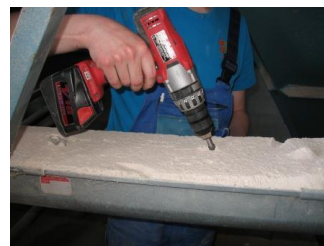
Akku boremaskine afmonterer skærm over U-rende.
