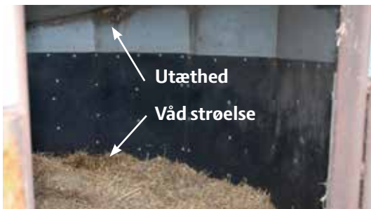
Er der utætheder i hytten, skal de lappes. Foto: Heidi M. Andersen
