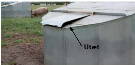
Ventilationsåbning skal repareres, kan ikke lukke tæt. Foto: Heidi M. Andersen
