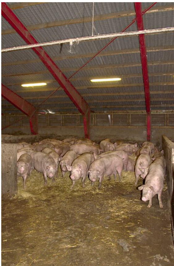
Stald med loft af stål (5205)
