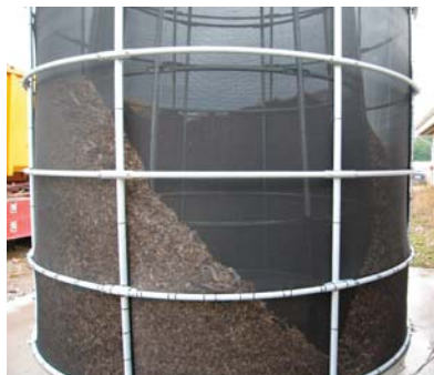
Øverst de to vertikale biofiltre ved en FRATS-stald. Nederst illustration af den koniske opbygning.
